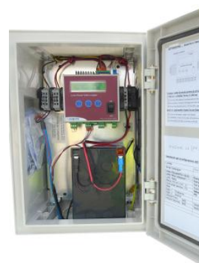
Montaggio nel quadro IP65 per esterni
