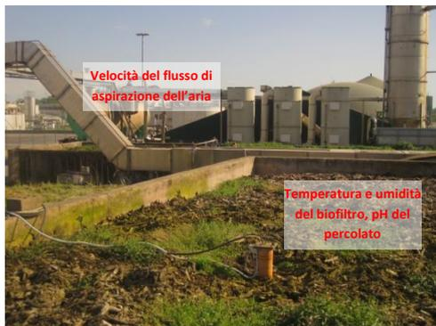
Monitoraggio della temperatura e umidità del biofiltro, del flusso dell'aria aspirata e del pH del percolato
