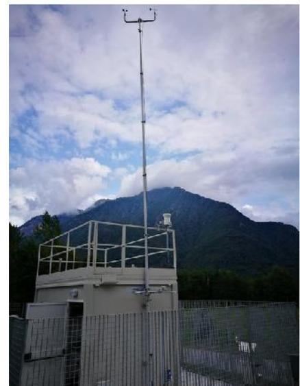
Stazione meteorologica su palo telescopico pneumatico h=10m. Installazione per cabina di analisi qualità dell'aria
