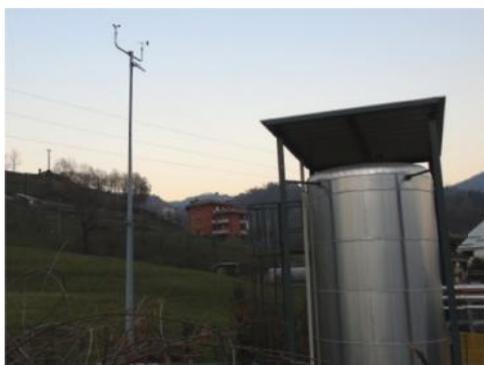
Stazione meteorologica con palo da 10m per il monitoraggio della dispersioni di inquinanti atmosferici (installazione in Impianto di cogenerazione)
